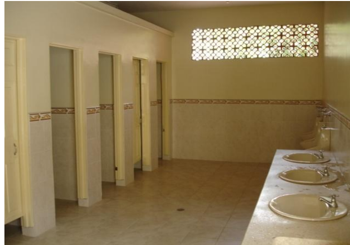
Baños de Hombres, ubicados en el primer piso
